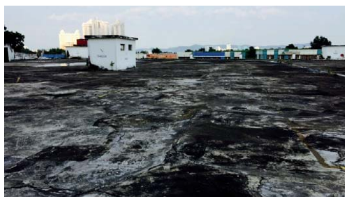
Parkdeck vor der Sanierung
