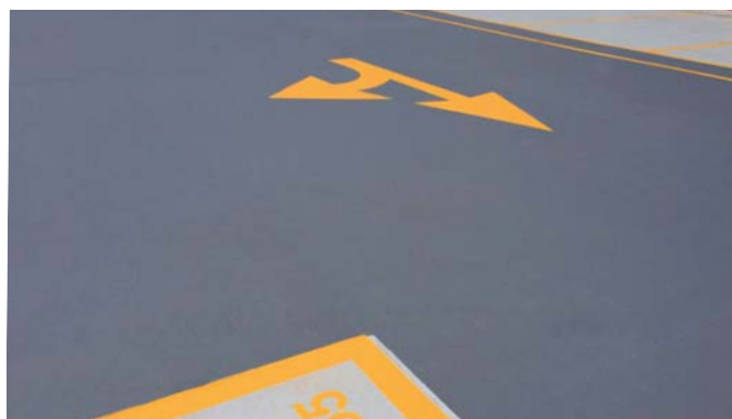
... und nach der Instandsetzung
