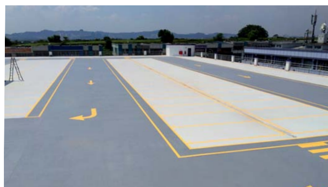
Zeitgemäße Wirkung nach der Sanierung
