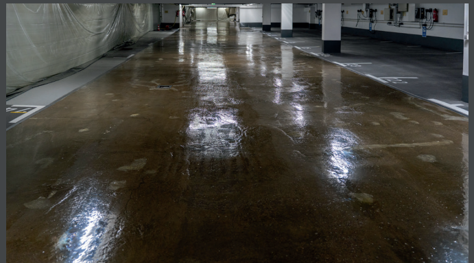
Grundierung EP-T703 SN
