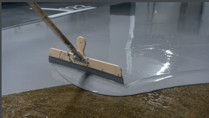
Applizieren der hwO VIASOL PU-L2000
