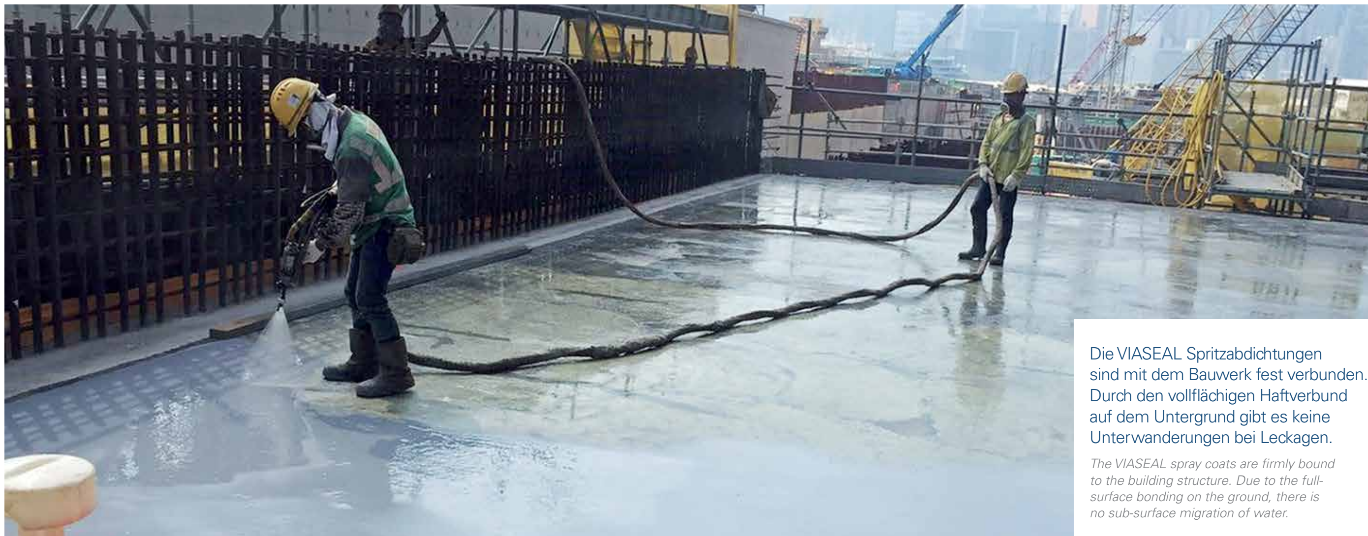
Auf der Baustelle in Asien | At the job site in Asia
