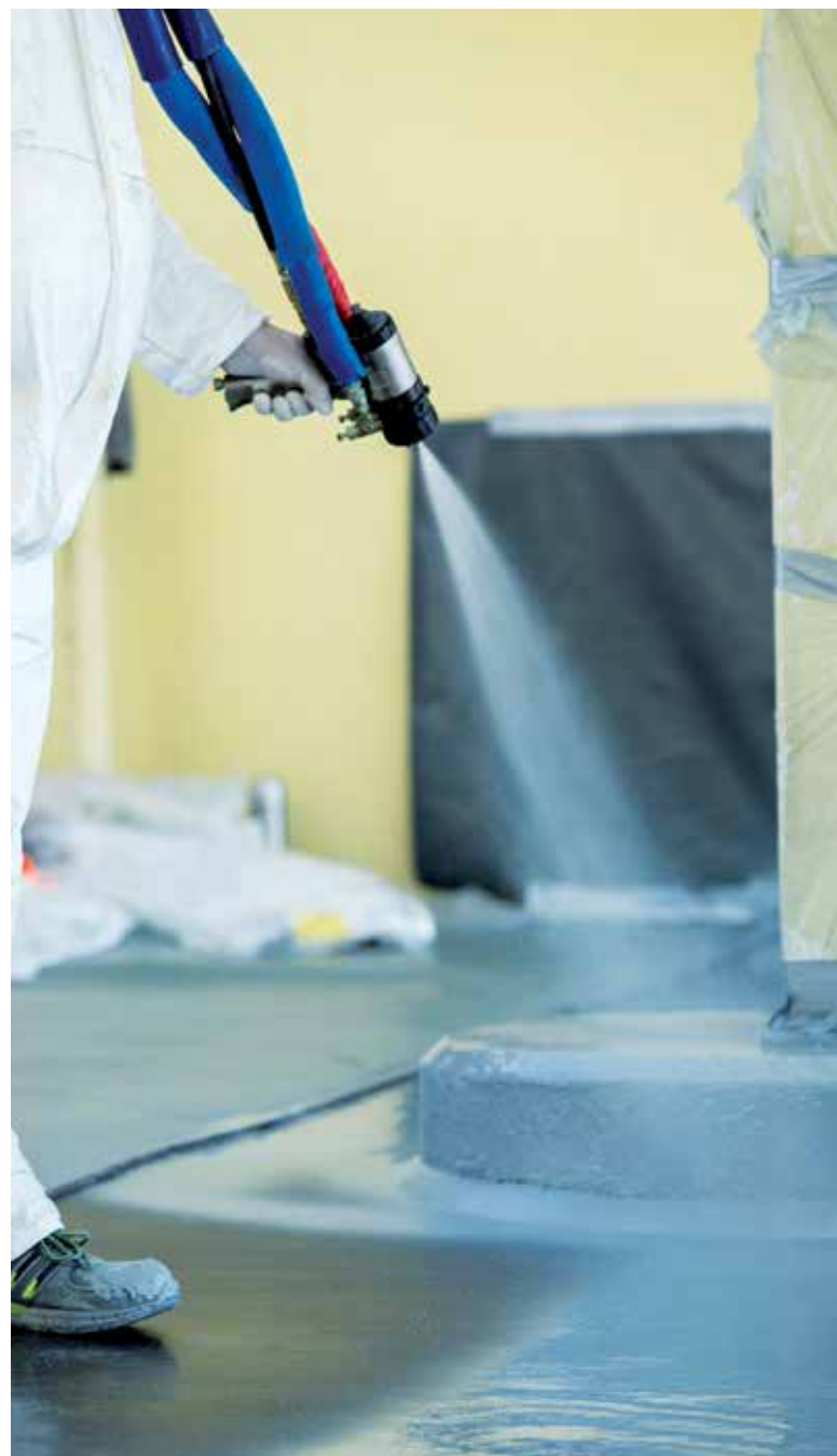
Auf der Baustelle in Esslingen | At the job site in Esslingen
