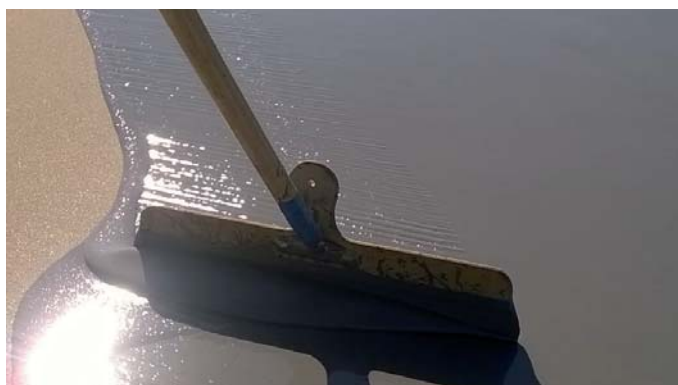
Aufbringen der Versiegelung
