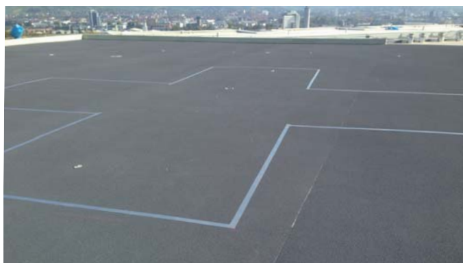
Vorbereitung für das Aufbringen der Linierung
