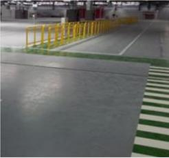
Leitfähigkeit / Ableitfähigkeit<br>Mit ESD-Einpfele oder mit leitfähiger ESD-Versiegelung | EN 1081                                         | $\leq 10^6 \Omega$ (Rg)                                         |
