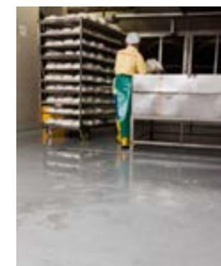
Molkereien und Käsereien benötigen eine hygienische Umgebung, denn Keime und Bakterien lieben Milch. Die fugen- und nahtlosen **VIACRETE** Bodenbeschichtungen geben Mikroorganismen und Keimen keinen Nährboden. Ein Grund dafür ist die porengeschlossene, fugenlose Oberfläche – die Beschichtung nimmt kein Wasser auf, sodass sich nichts im Bodenbelag festsetzen kann.
