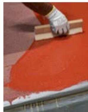
Die **VIACRETE** Industriefußböden für die Lebensmittelindustrie halten diesen extremen Bedingungen stand. Beispielsweise bei Belastungen durch Heißwasser in den Kochzonen, durch Spillagen mit Ölen aber auch durch thermische Schockbelastungen in Kühl- und Tiefkühlzonen von -45 °C bis 130 °C. Selbst bei gleichzeitiger Einwirkung mechanischer Kräfte oder von Chemikalien bleibt der Boden unbeschädigt.
