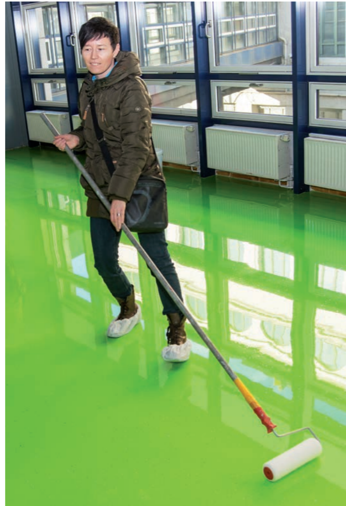
Auf der Baustelle | At the job site
